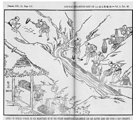
San-kai-mei-butsu-dzu-yé. Vol. I, Tab. 16. Lavage du minéral d'oxyde de fer magnétique ou du fer titané magnétique sablonneux sur des nattes dans une fosse a eau courante.
