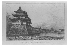
Shiro ou Castel de l'ancienne noblesse féodale du Japon. 城すなわち日本の昔の封建貴族の城
