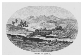
Brücke bei Lantjen. ランティエン[南甸]近くの橋
