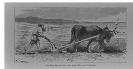
Am Ufer des Pei-Ho. ペイホー[白河]の岸で
