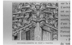
Encorbellements du toit à Tshiôn. 知恩院の屋根の持出し構造[組物]
