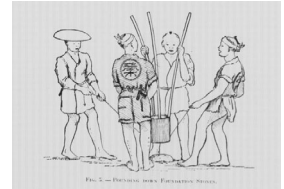
Fig.5. - Pounding down foundation stones. 図5. 基礎石の打ち込み
