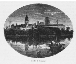
Docka i Bombay. ボンベイのドック
