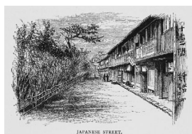
Japanese street. 日本の通り
