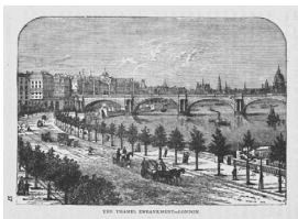
The Thames embankment - London. テムズ川の堤防 - ロンドン
