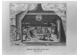
Barents' hus (bild af det inre). バレンツの越冬小屋(内部)
