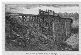
Pont en bois du chemin de fer du Pacifique. パシフィック鉄道の木製の橋
