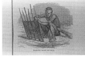
Making door of hut. 小屋の戸を作る
