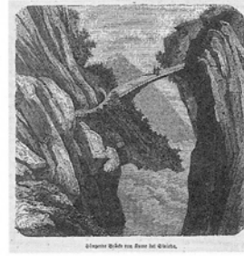
Hangende Brücke von Rumo bei Simoda. 下田近くのルモ[竜王か]の吊り橋
