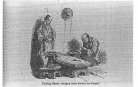
Chasing floral designs from nature on copper. 実物をモデルとして銅版に花模様を彫っている
