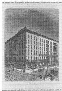
Shermanhouse. シャーマンハウス
