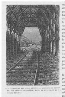
Central-Pacific, dans la traverse de la Sierra Nevada. セントラルパシフィック鉄道の シエラネヴァダ山脈越え
