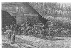
La voiture d'Idaho (Nevada), sur le chemin de fer Central- Pacific. セントラルパシフィック鉄道のアイ ダホ(ネヴァダ)からの駅馬車
