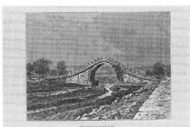
Pont dans le palais d'Ete. 夏の宮殿の橋[頤和園玉帶橋]
