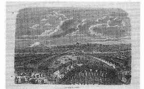
Le pont du Nippon 日本橋
