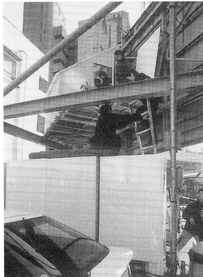
④ 「ビルボードの家」 "The Billboard House" under Construction
