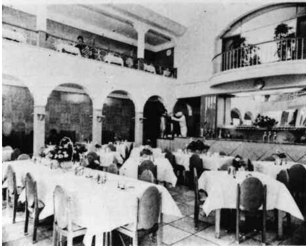
図6 震災後の本建築（内装）
