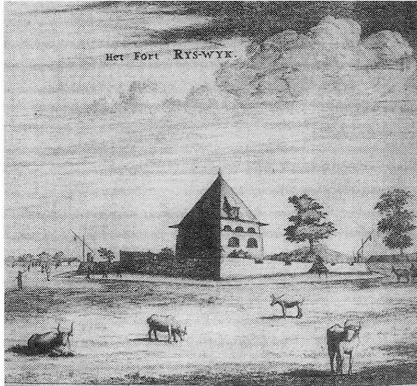
図 53 ヨハン・ニューホフ『東西海陸紀行』《バタビアのライスツァイク砦》Het Fort Ryswyk
